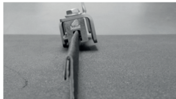
8 – INSTALLAZIONE ERRATA
